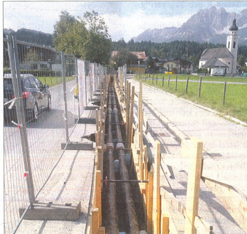
Im Sommer wurden in der Bahnhofsstraße die Fernwärmeleitungen verlegt.
