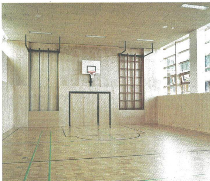
Freundlich, hell und modern – der generalsanierte Turnsaal in Oberndorf.
